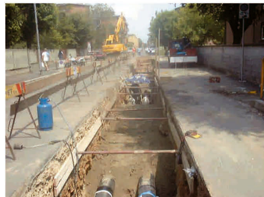
Lavori per la creazione della rete di teleriscaldamento
