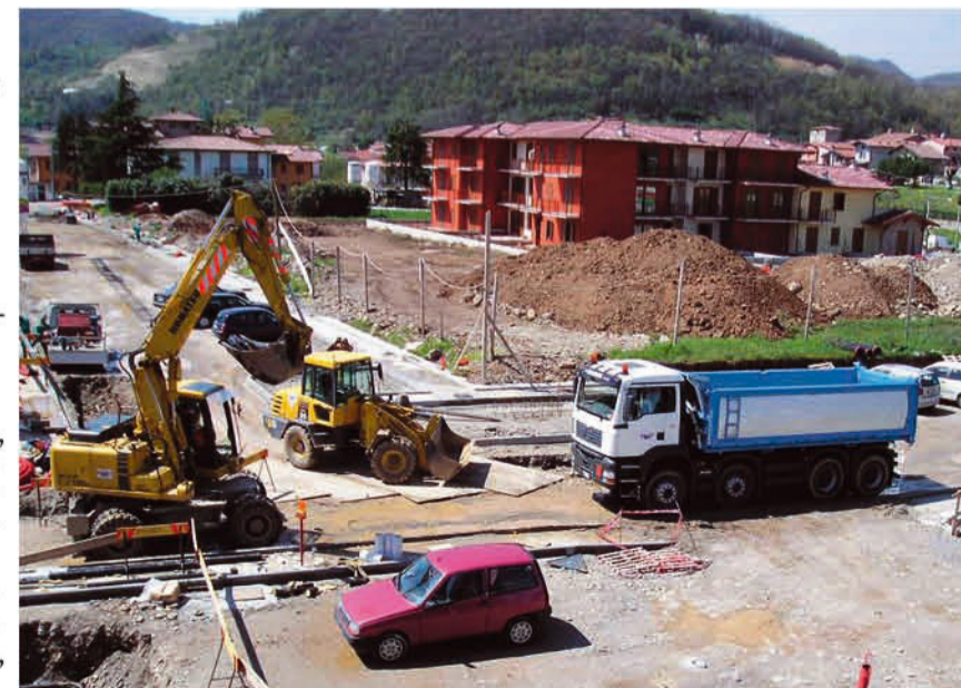
LAVORI SAN FERMO - CREDARO
