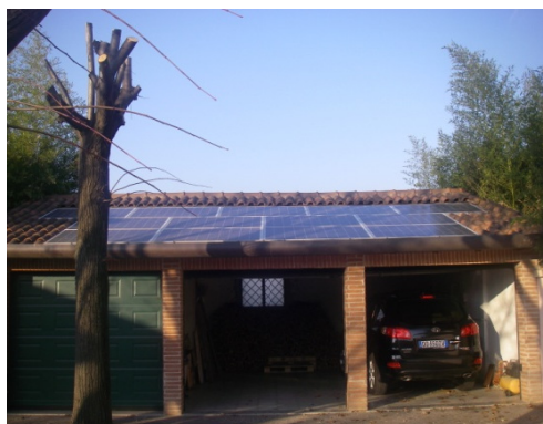
Privato 3,1 kWp (VA)
